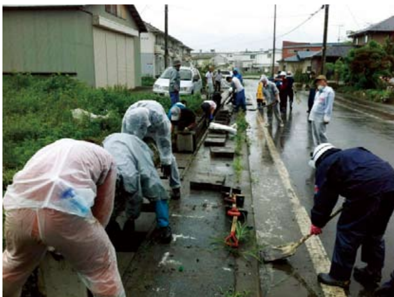
写真11 大船渡市での作業（側溝の汚泥除去）
